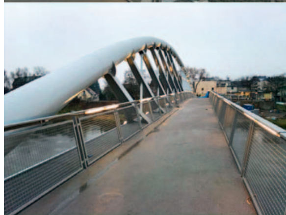
Fot. 4. Pomost po otwarciu obiektu
