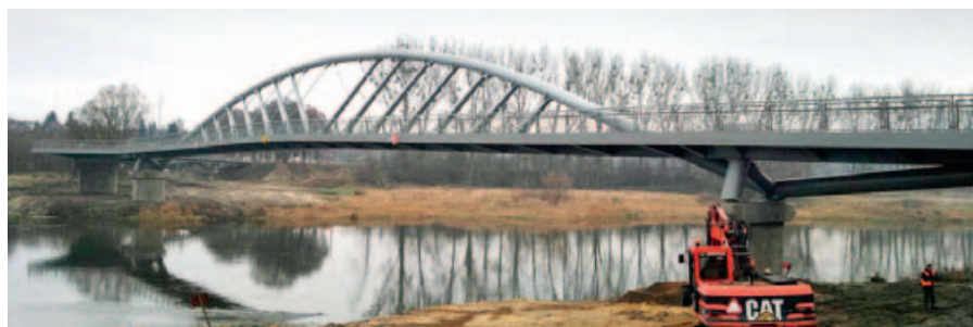
Fot. 3. Kładka w okresie procedur odbiorowych
