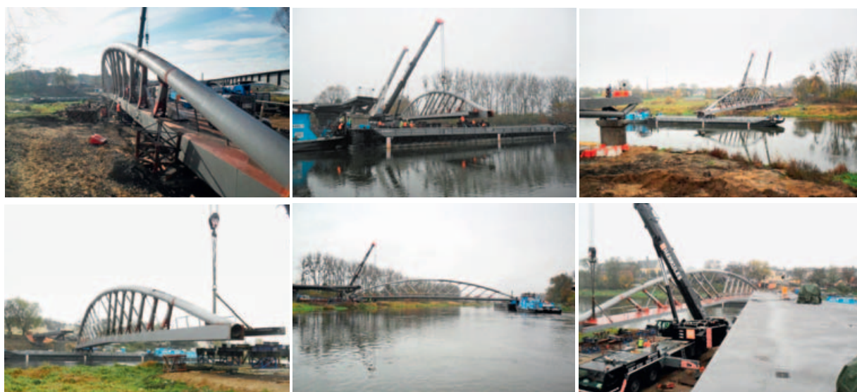
Fot. 1. Montaż przęsła nurtowego
